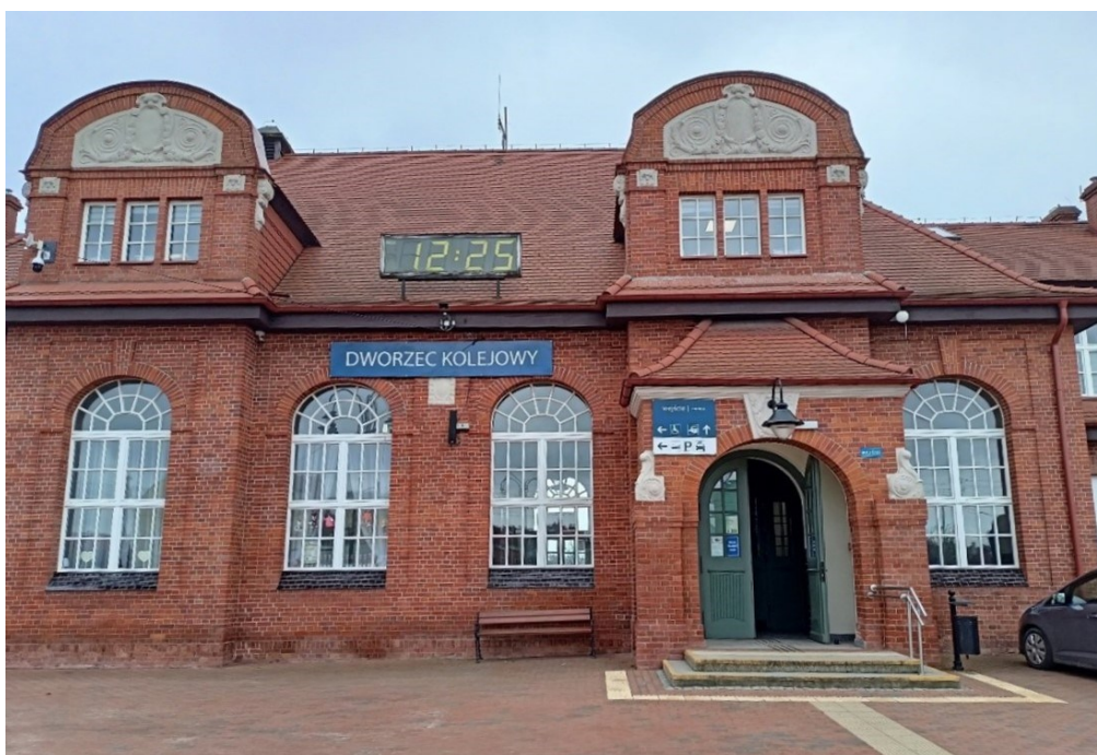
Rysunek 14. Zmodernizowany dworzec kolejowy w Tucholi
