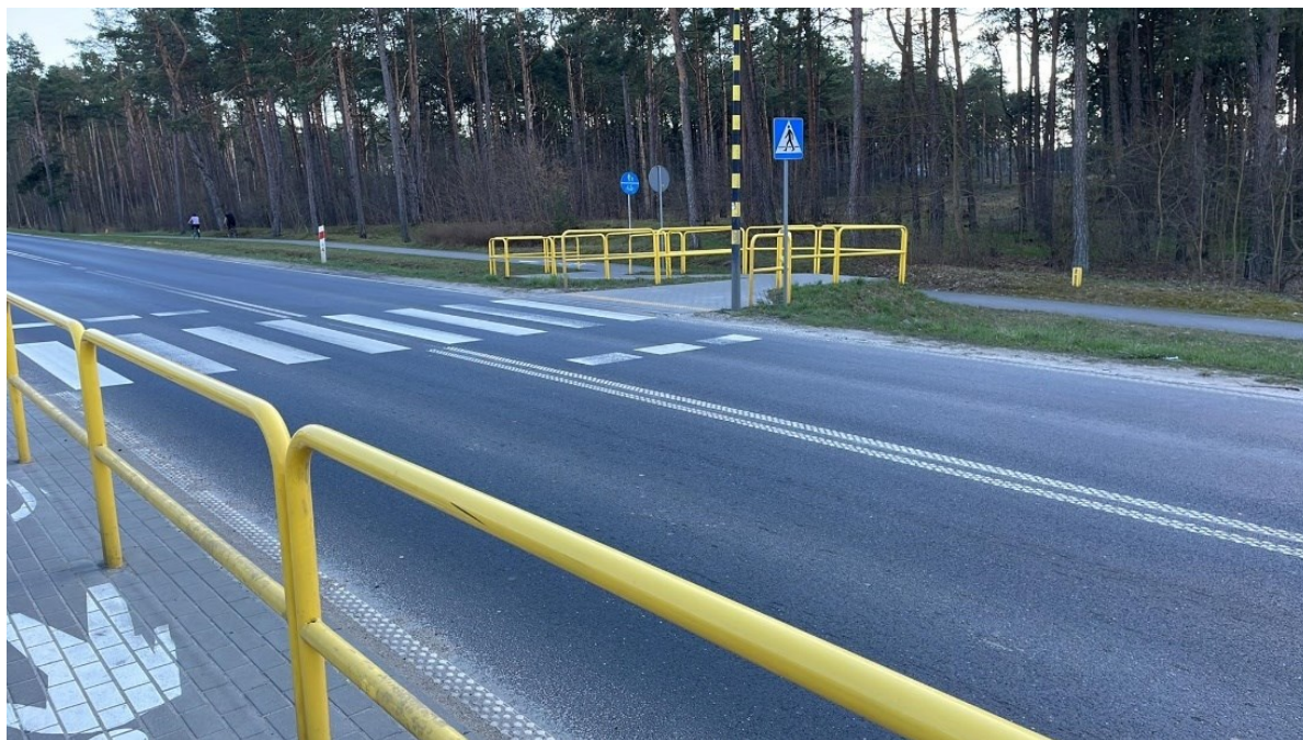
Rysunek 22. Przejście dla pieszych w ciągu DW240
