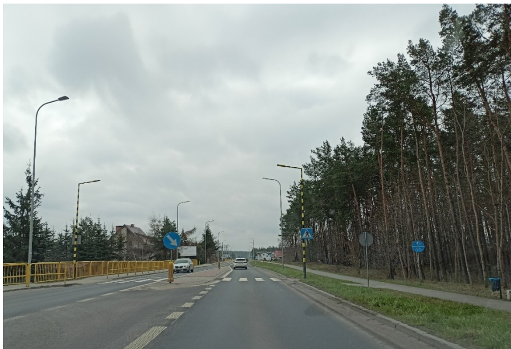
Rysunek 20. Zmodernizowana DW240
