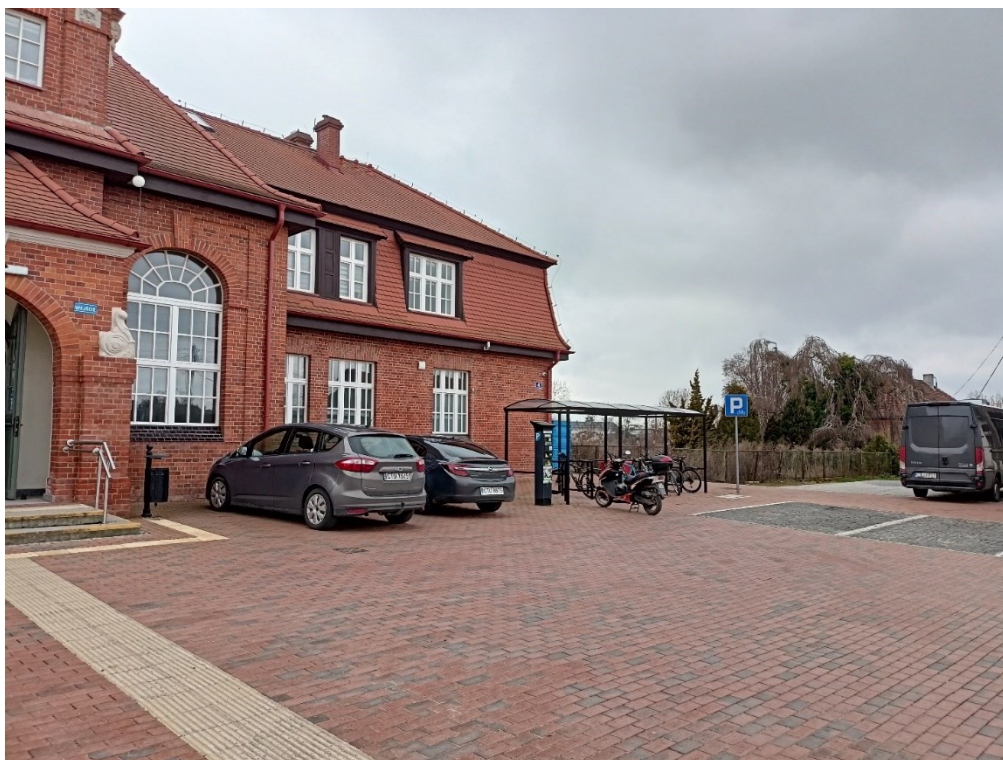
Rysunek 15. Zadaszony parking rowerowy zlokalizowany przy zmodernizowanym dworcu kolejowym w Tucholi
