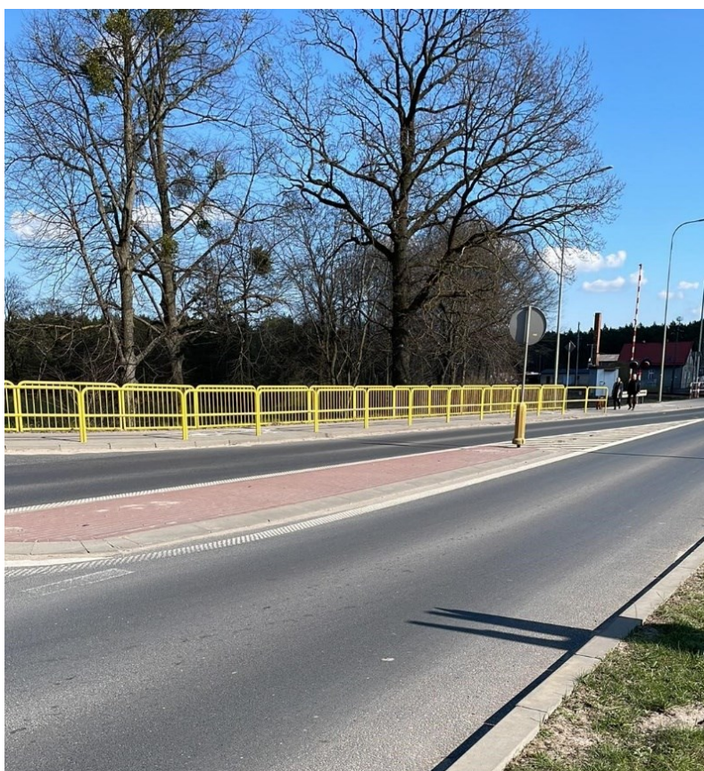
Rysunek 23. Wyspa dzieląca w ciągu DW240
