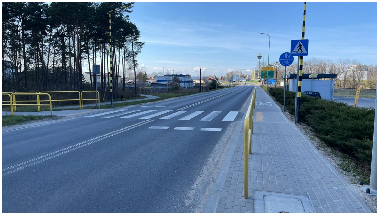
Rysunek 21. Zmodernizowana DW240
