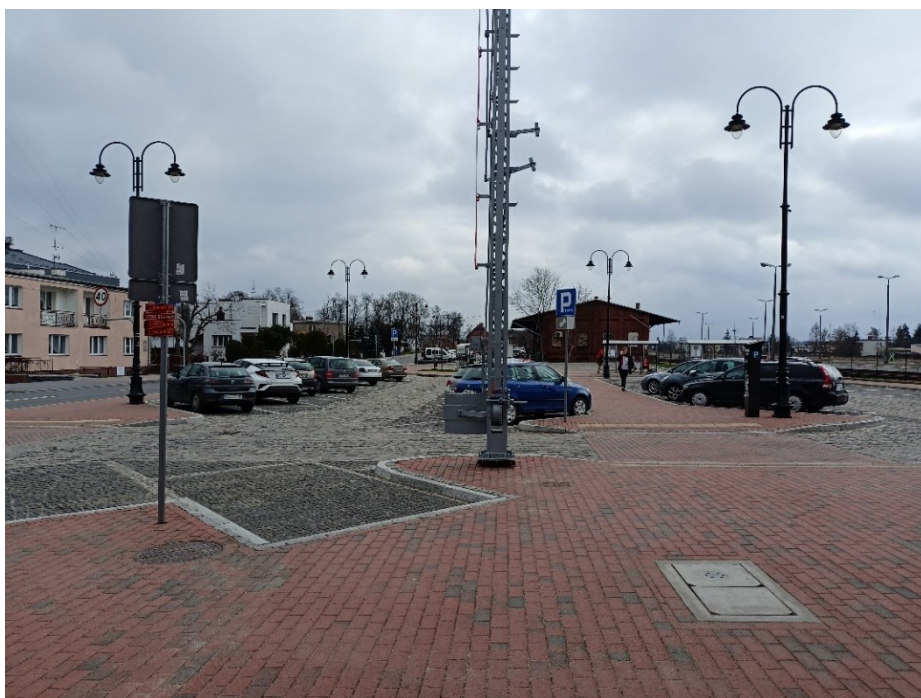
Rysunek 16. Parking zlokalizowany przy zmodernizowanym dworcu w Tucholi
