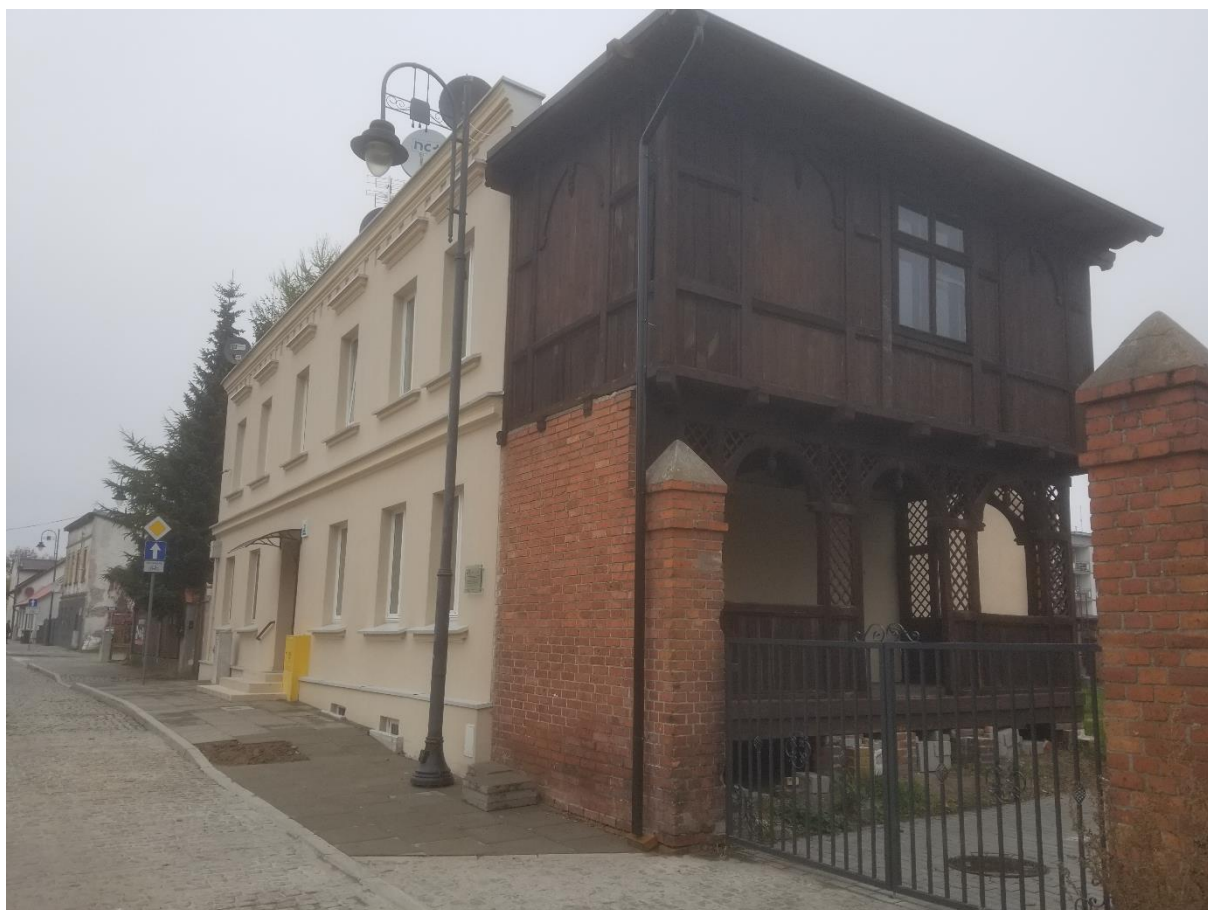
Zdjęcie 5 Kamienica na ul. Kapeluszników 2 wraz z zabytkową kuczką po rewitalizacji
